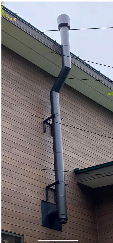
煙突に二つ割ステーを巻き、破風板に支持足を固定してブレ止めする。
